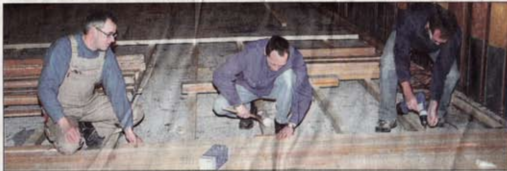
Hochwertige Lärchenbretter bilden den neuen Bodenbelag der vereinseigenen Schützenhalle. Viele Helfer fanden sich bei den Arbeitseinsätzen ein. ■ Foto: Franke
