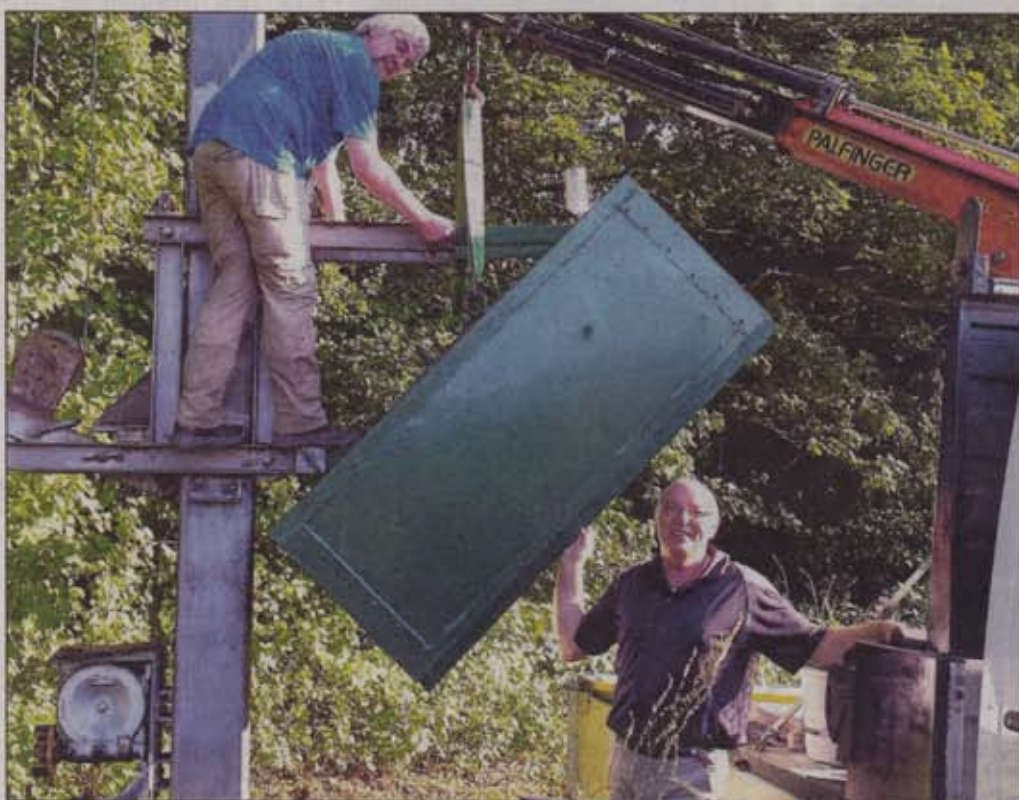
Der „Probe-Hub“ ist geglückt, dem Buschauftsetzen am Samstag steht nichts im Wege. • Foto: Franke
