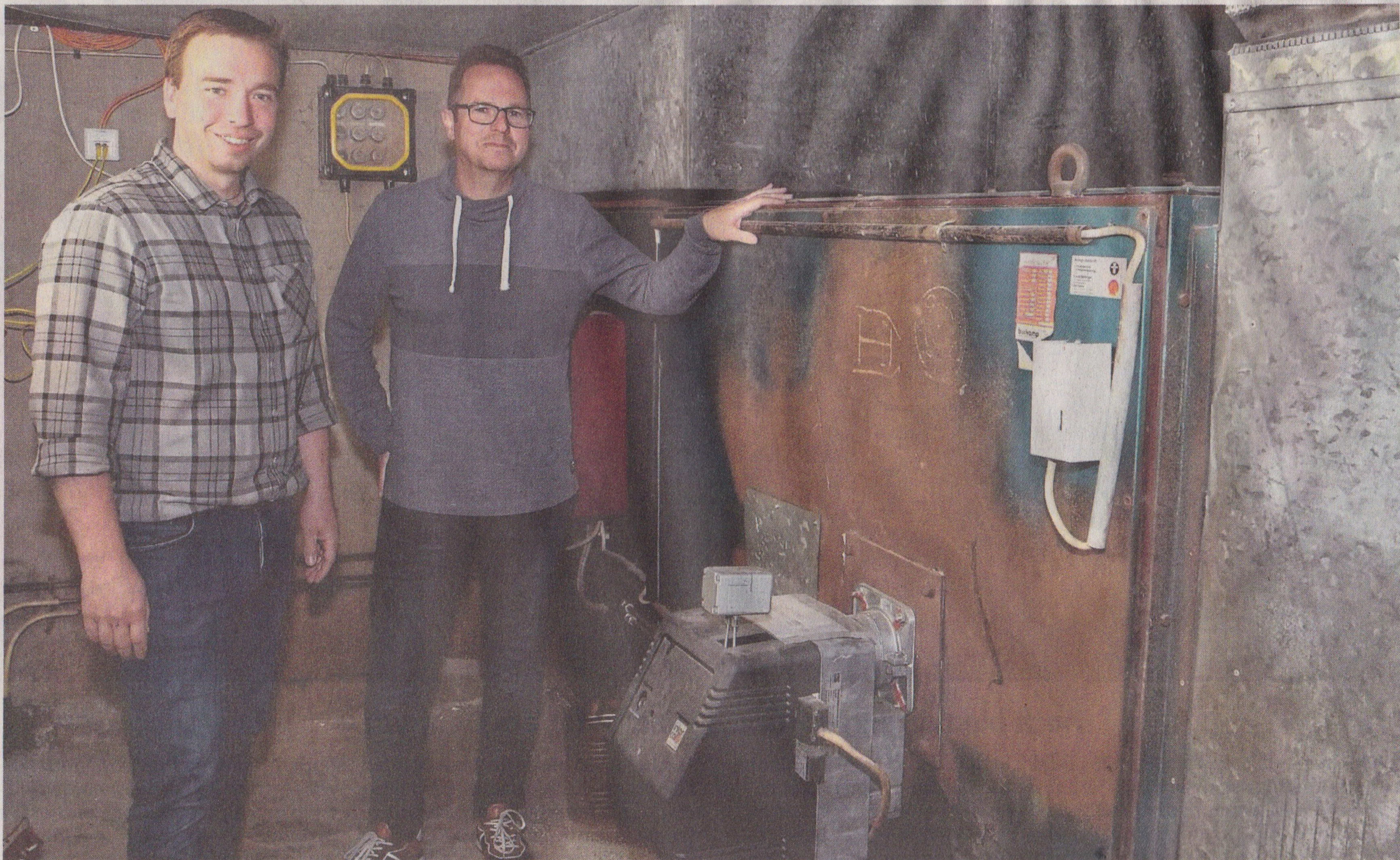
Freude über die Förderung: Oberst Hubertus Struchholz (links) und Rendant Martin Kellerhoff im alten Heizungsraum der Möhnetalhalle.
