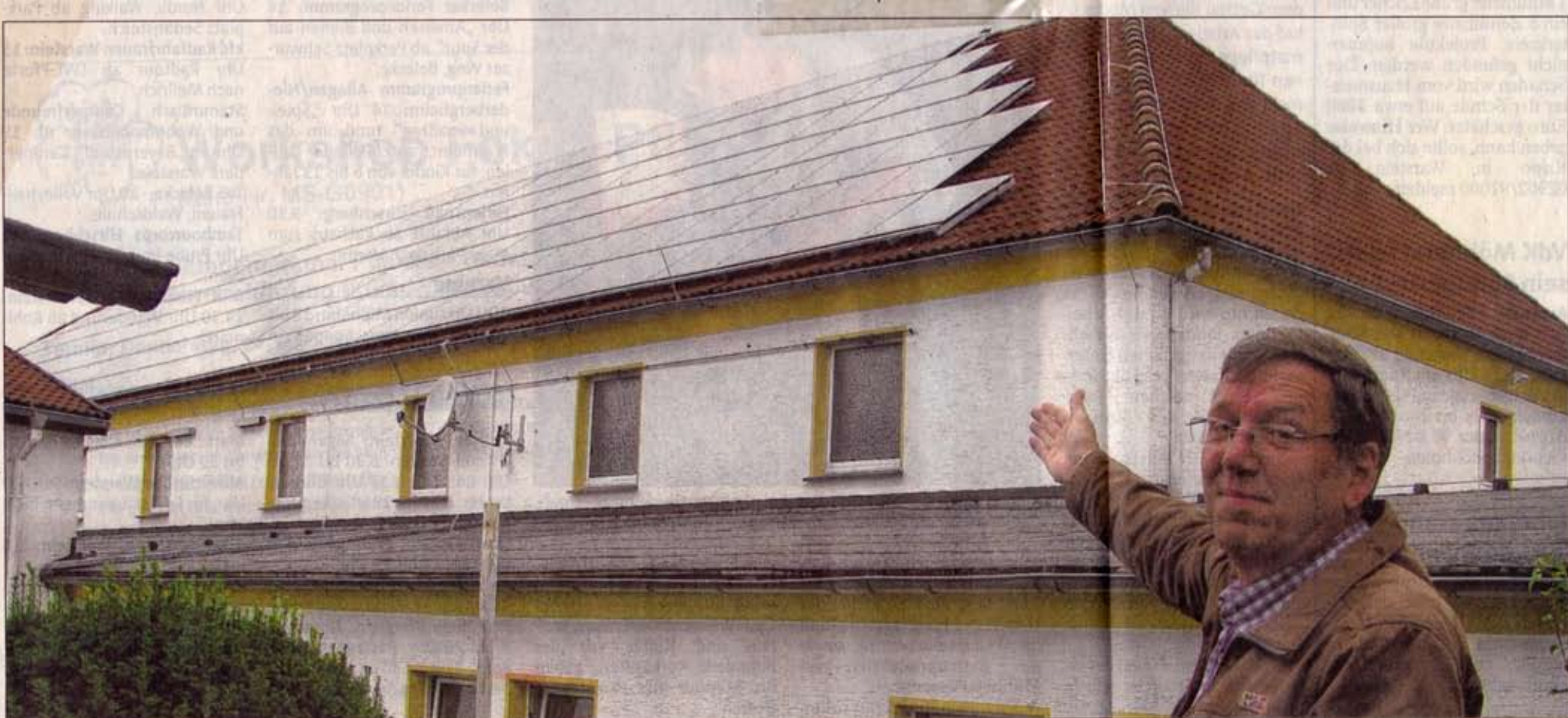
Seit 2009 produzieren die Allagener Schützen Strom auf dem Dach der Möhnetalhalle. Die Erträge bewegen sich im Rahmen der Kalkulation. Nach 20 Jahren fester Einspeisevergütung hofft Rendant Hans-Jürgen Severin, die Halle dann autark betreiben zu können. Fotos: Manfred Böckmann
